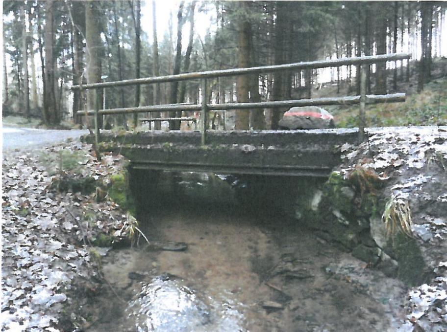
Der Überbau der Brücke wurde aus Stahlbetonplatten, die auf den Unterflansch von Profilstahlträgern aufgelagert sind, erbaut.
