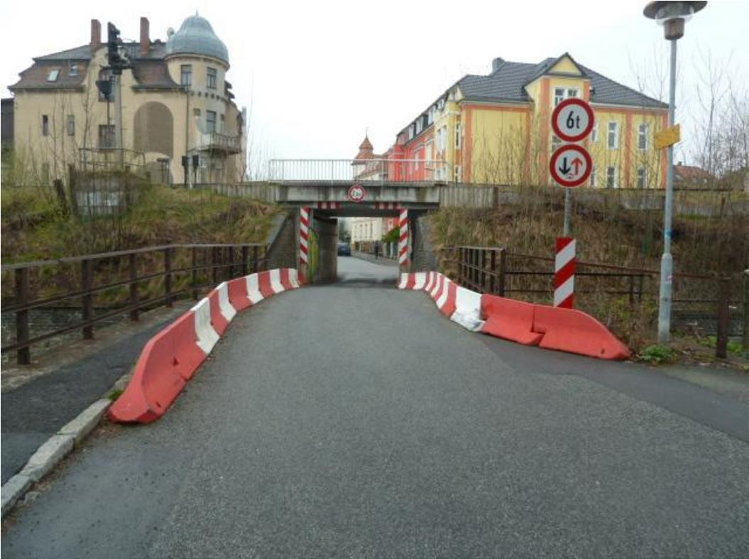
Der Überbau der Brücke wurde aus Profilstahlträgern mit Betonverguss erbaut. Über die Profilstahlträger wurde eine Stahlbetonplatte angeordnet. Diese bildet auch die Kappen.
