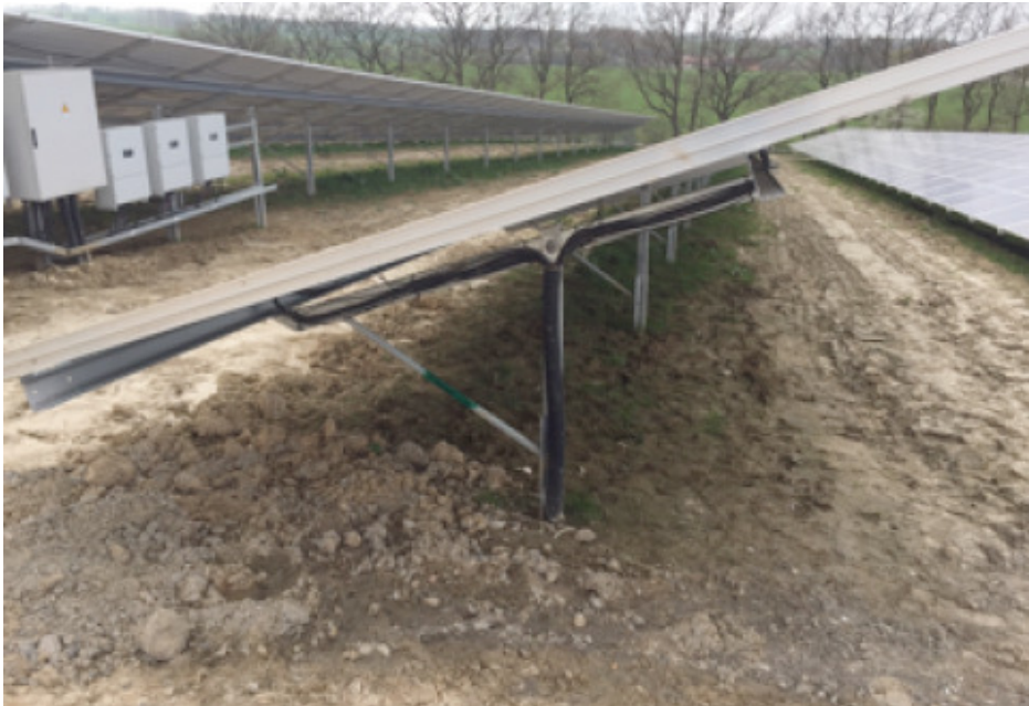
Abb.3: Darstellung der geplanten Tischkonstruktion (während der Bauphase)
